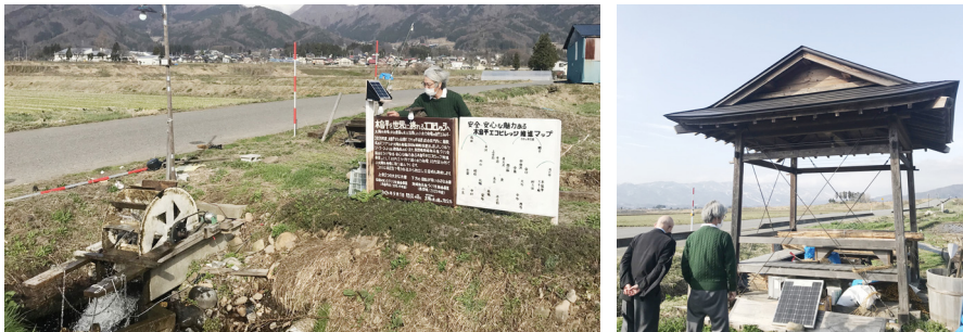
田圃横の水路に設置された水車。発電した電気は近くの東屋の照明の電源となっている
